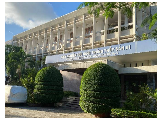
Hình 1.5. Khu nhà làm việc 3 tầng
